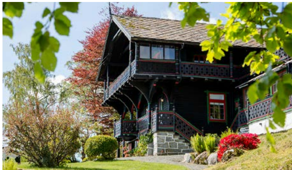
Joachim Griegs sommarhus frå 1904 – ein loftsbygning i nasjonalromantikkens formspråk.
